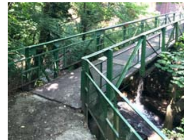
Le remplacement de la passerelle Rue des Boulangers est programmé.
