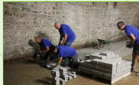
Foyer Saint-Grégoire : pavage du garage
