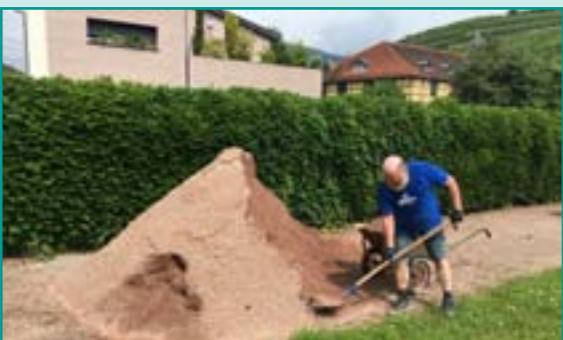
Nivellement et nettoyage des allées
