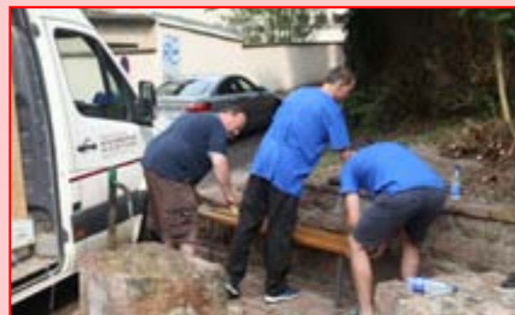
Réparation des bancs publics
