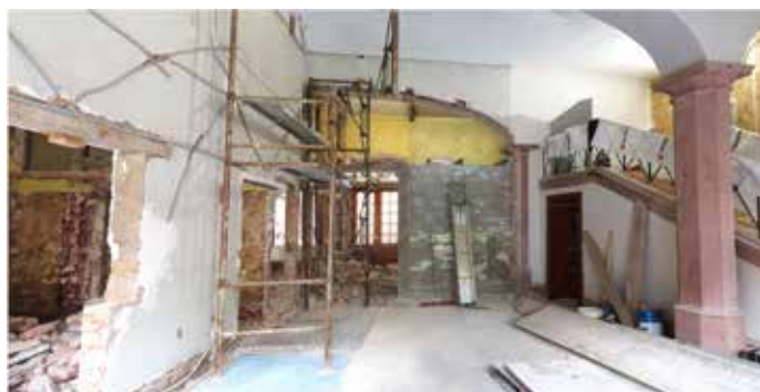
La voûte du fond a refait son apparition pendant les travaux de transformation.
