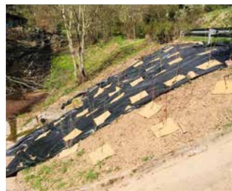
Déversoir d'orage au plateau sportif
