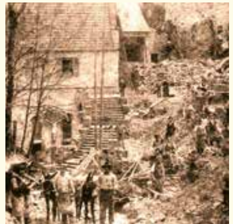
La nouvelle église en construction (1902-1903)
