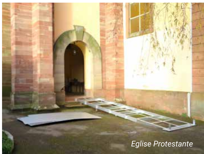
Les rampes en cours de pose
